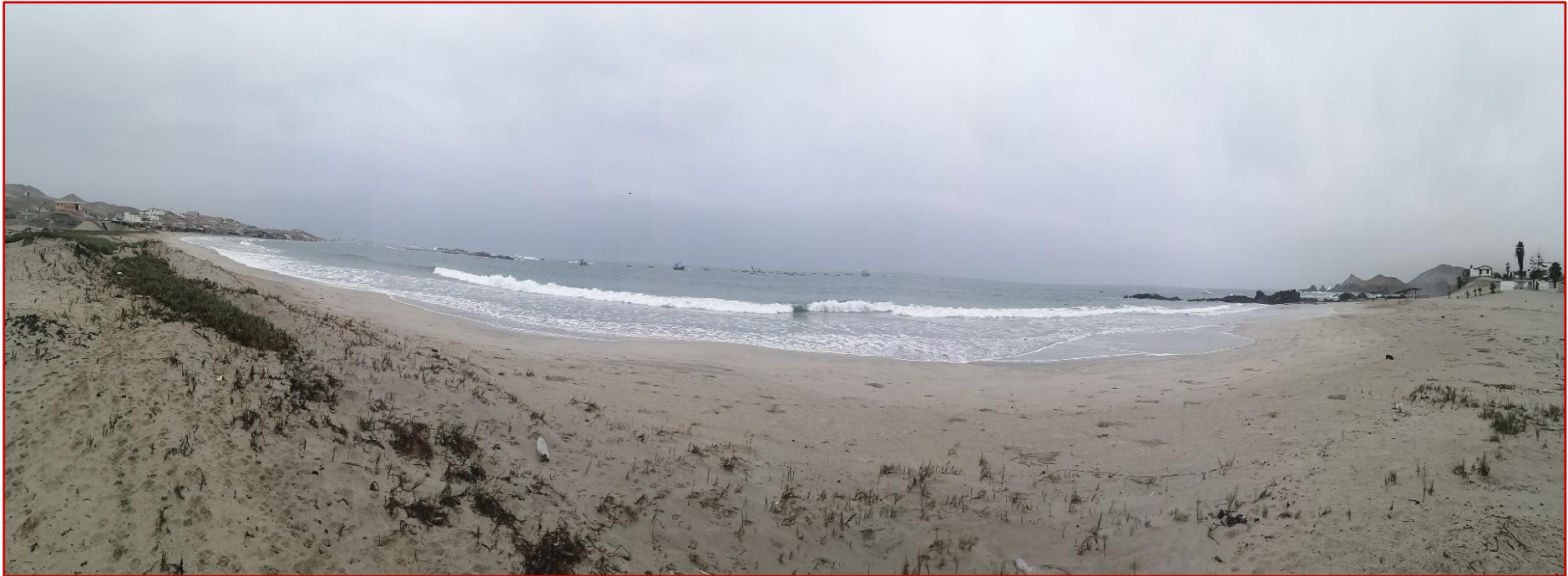
Foto N° 05: Vista panorámica (dirección de sur a norte), de la zona costera aledaña al área de estudio, esto determina que se deberá de proyectar y construir un enrocado que permita mitigar el impacto de la consecución de posibles oleajes anómalos.
