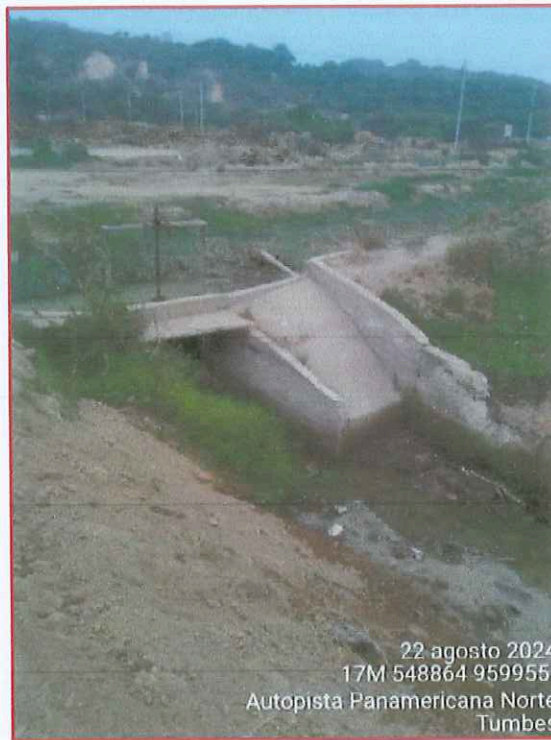
Foto N° 03: Compuerta de ingreso al dren artificial de Los Cerezos (lateral J-L), que desemboca en el mar.
