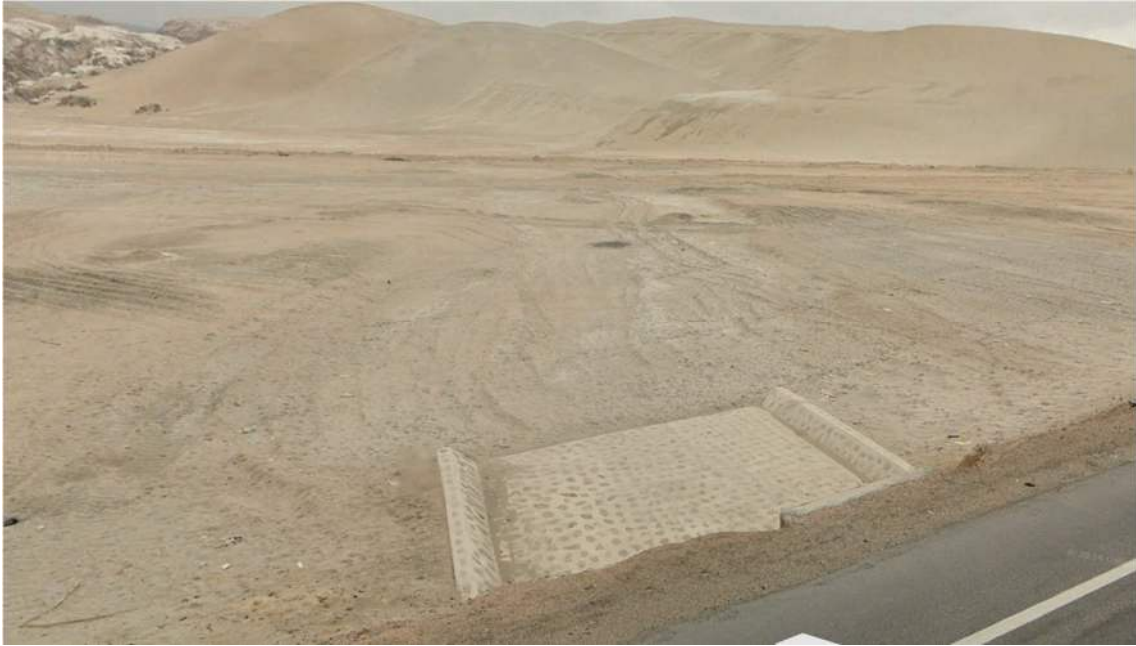
Foto N° 03: Se observa la alcantarilla existente, la cual permitiría el encausamiento de las aguas de la quebrada Pampa Chilcas, siendo responsabilidad de la autoridad competente en materia de administración de la cuenca.
